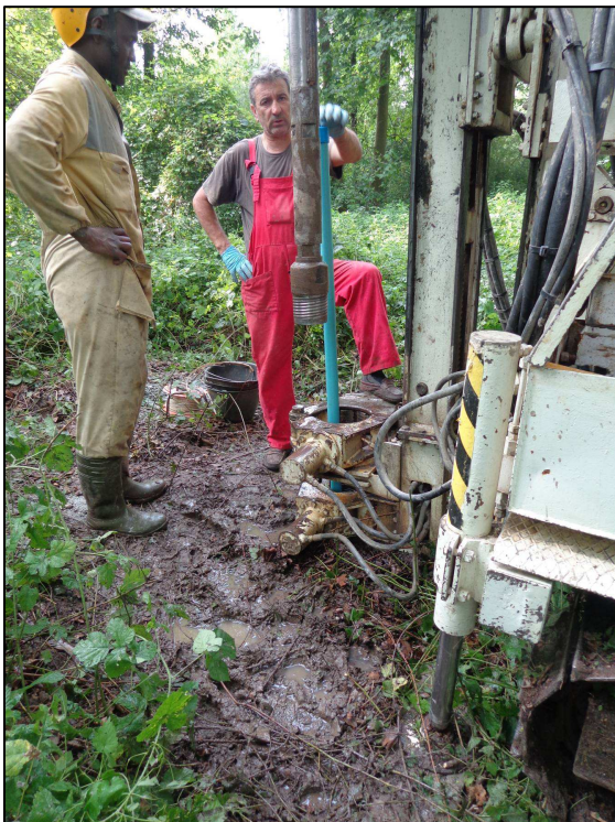
posa tubo piezometrico
